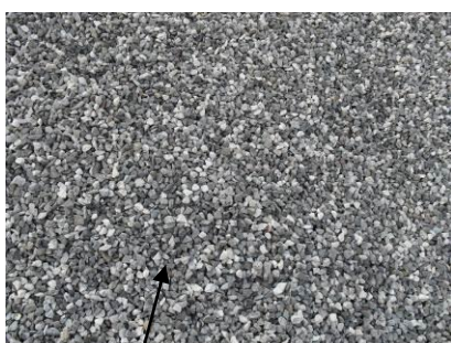
Pavimentazione in ghiaio in testa alle terre armate
